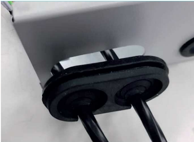
Inserire i tubetti del cavo nell'alloggiamento ovale del box prestando attenzione a non danneggiarli.
